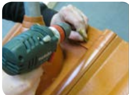
DuroVent Durchgangspfanne anschrauben
