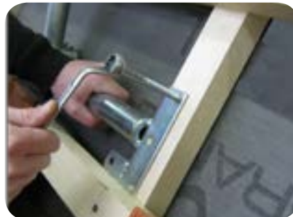
Befestigung mit beige-packten Schrauben
