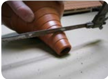
Durchgangsloch des DuroVent Antennendurchgangs anpassen
