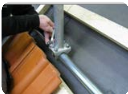
Schrauben zur Befestigung der senkrechten Stange anziehen
