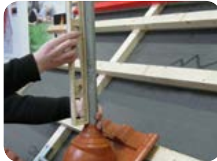
Antennenhalter senkrecht ausrichten
